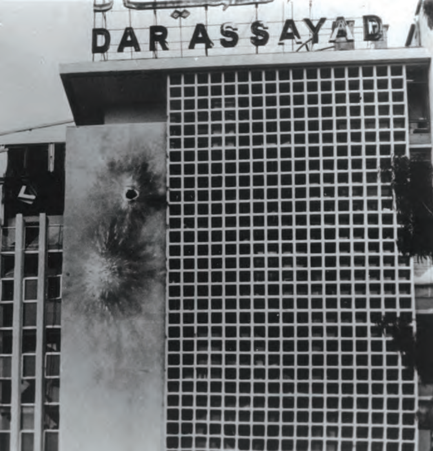
آثار القذائف ظاهرة على واجهة المبنى الرئيسي لـ «دار الصياد»
